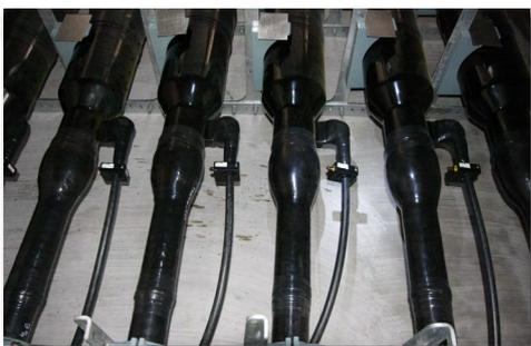
Instalación en EMPALMES DE CABLE CON SECCIONAMIENTO DE PANTALLAS, alrededor de las conexiones de cables fuera de la caja de conexiones (link-box).
