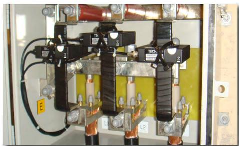
Instalación en EMPALMES DE CABLE CON SECCIONAMIENTO DE PANTALLAS, alrededor de las conexiones de cables dentro de la caja de conexiones (link-box).
