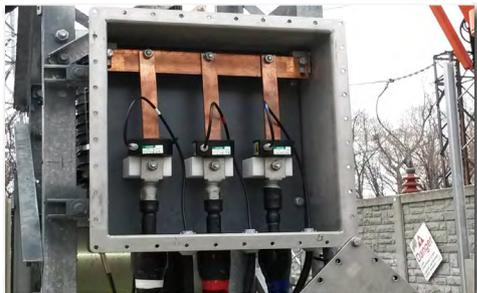
Instalación en TERMINACIONES EXTERNAS, dentro de la caja de conexiones de tierra.
